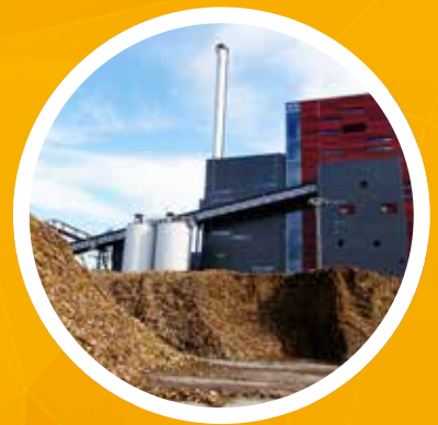
Energieerzeugung, Biomasse & Holz
